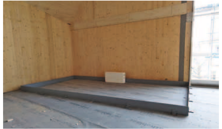
Im Saal wurde der Rahmen für die Bühne eingebaut (Foto: Nadine Höhne)
